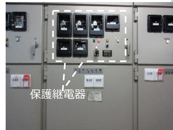
メタルクラッド開閉装置 (デジタル化前)
