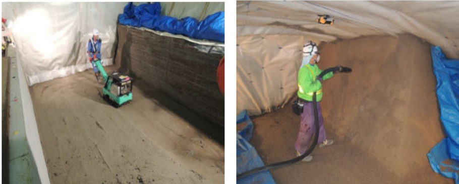
上部埋戻し材の施工例
