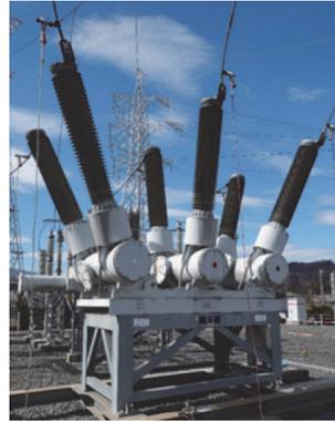
ポリマーがい管を用いた変電機器
