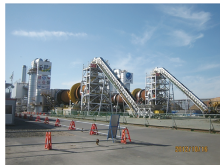
図2 東日本大震災時の災害廃棄物の仮設焼却炉 (石巻市, 2012年10月撮影)
