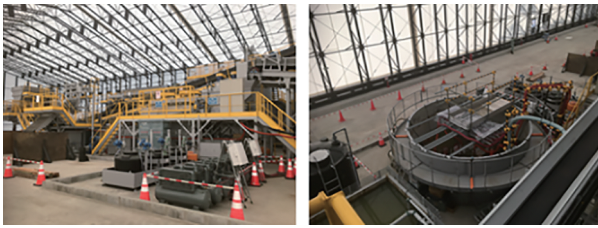
図1 汚染土壌の分級洗浄実証施設 大熊町の実証エリアで環境省事業として実施
