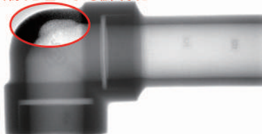
図1 配管の X 線撮影画像と減肉部分の鮮明化例
