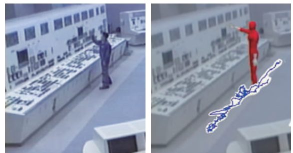
図6 運転員の移動軌跡と動作の認識例
