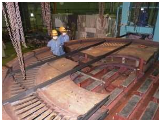
(解体撤去・切断)
