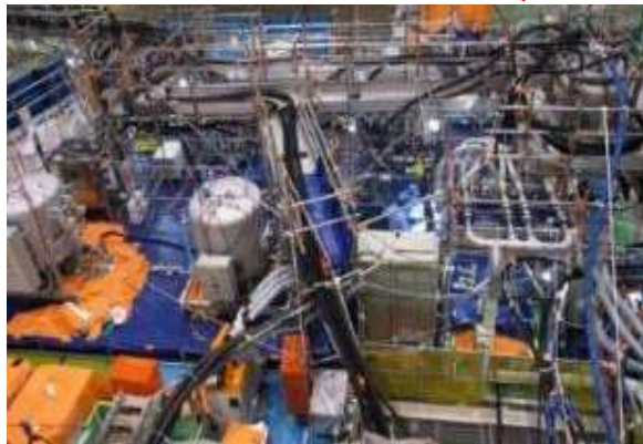
除染装置を撤去中
