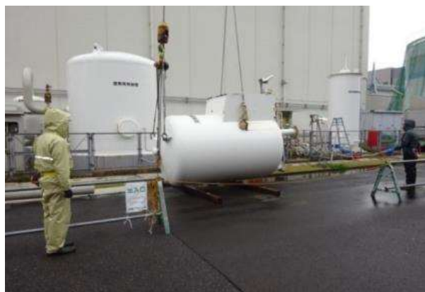
管理区域外にある設備の解体撤去
