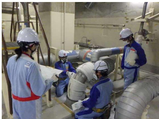
保温材取り外し後、配管切断
