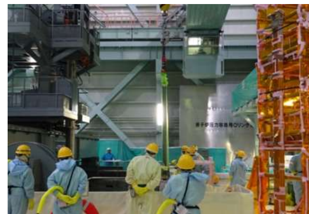
搬出・譲渡し前の新燃料除染作業
