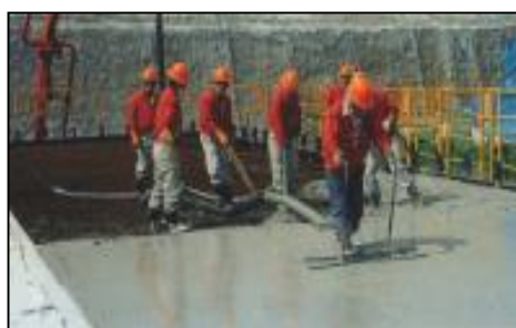
覆い(鉄筋コンクリート)を打設
