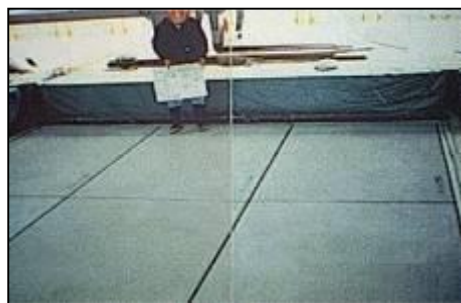
上部ポーラスコンクリート設置
