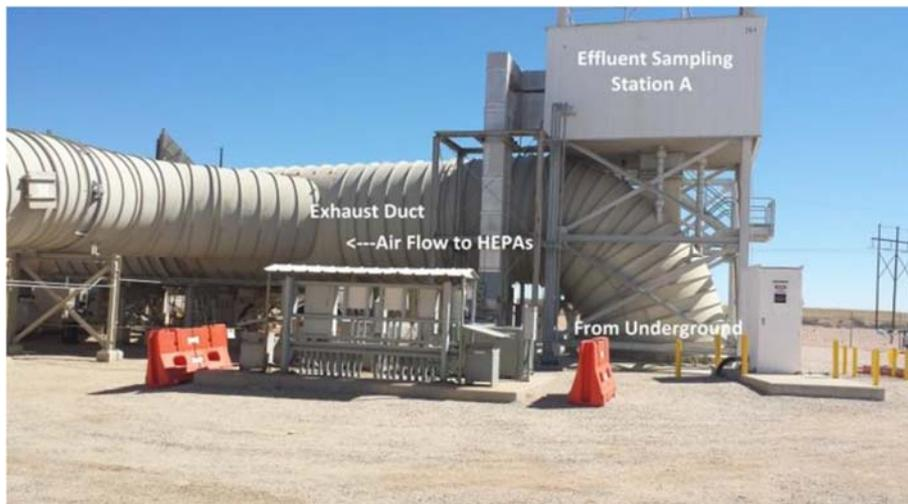
図 2.5.2-8 排気シャフト (HEPA 上流側) 及びサンプリングステーション A
