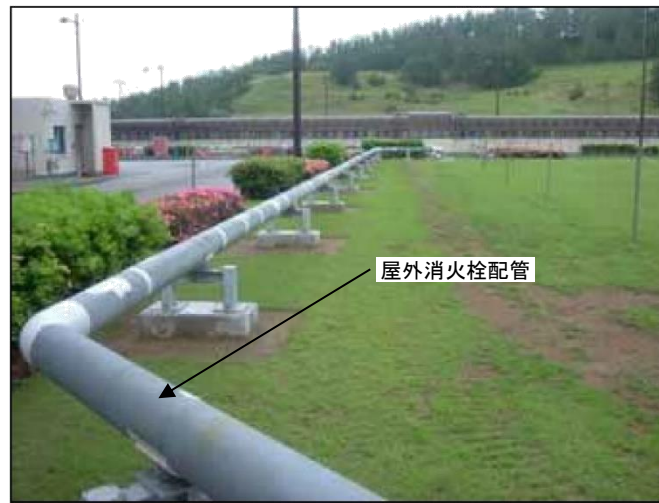
図Ⅲ.5-9 屋外消火栓配管の地上化
