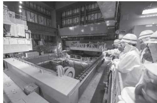
第1図 使用済み核燃料の保管プール崩壊が懸念された4号機の建屋内部の様子 耐震工事が終わり、プールが補強され、取り出し作業が進む。見学者は防護服、マスクを着けて視察する。(写真提供・Noriyuki Inoue / WEDGE)
