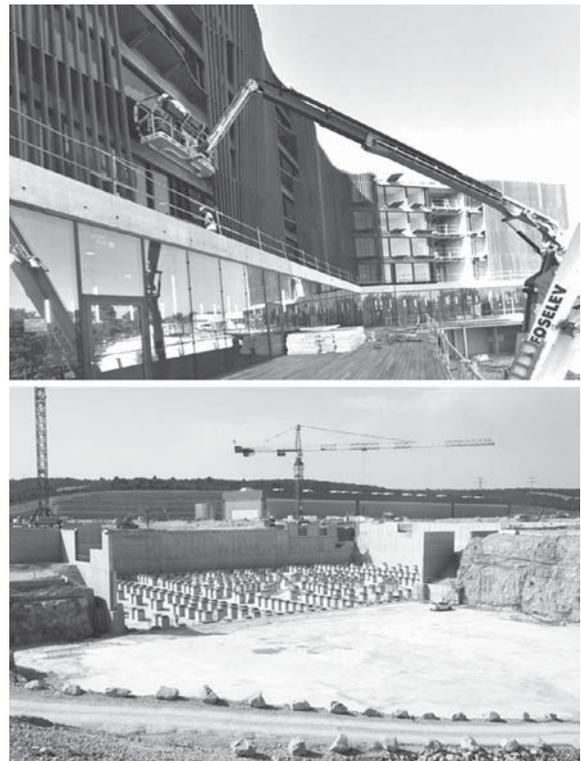
第5図 ITER建設状況<sup>1)</sup>(上:ITER本部建屋はほぼ完成、下:本体基礎を建設中)
