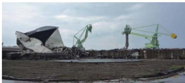
津波で流されたタンクと破壊された揚炭機(原町火力発電所)
