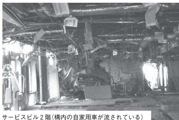
第5図 原町火力発電所サービスビル津波被害
