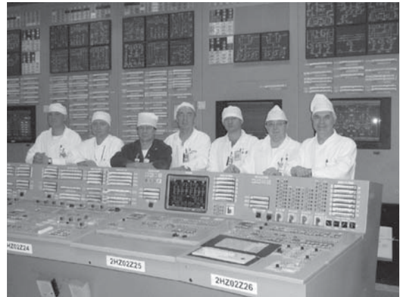
第2図 同原子力発電所の中央制御室 ©Ignalina NPP
