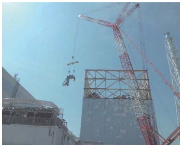
福島第一原子力発電所1号機の原子炉建屋カバー工事の模様(東京電力HP)
