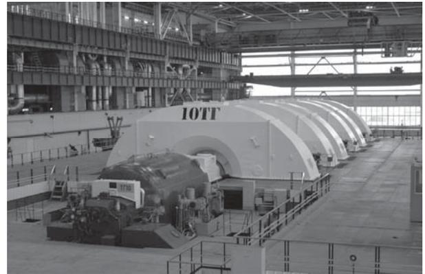
第2図 同原子力発電所のタービン ©Kozloduy NPP
