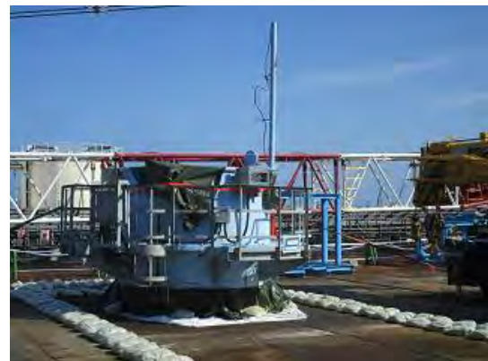
切断された排気塔先端部
