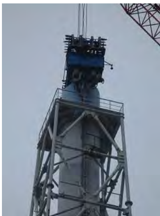
排気塔切断作業
