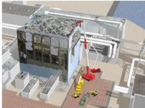
原子炉建屋上部のガレキ撤去
