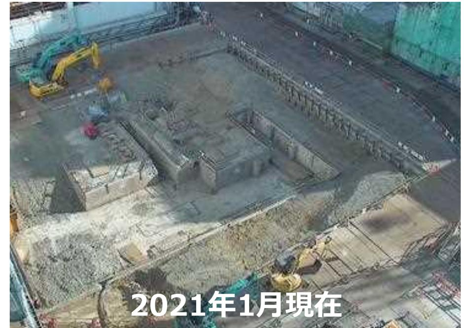
構台設置エリアの地盤改良工事を実施中
