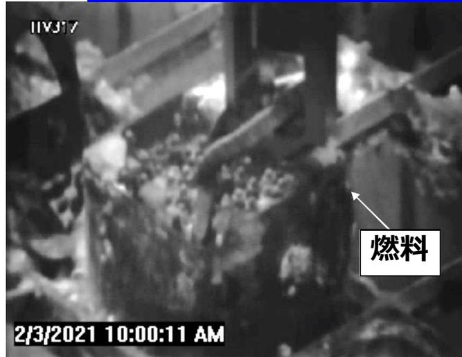
3号機でのハンドル変形燃料の吊り上げ
