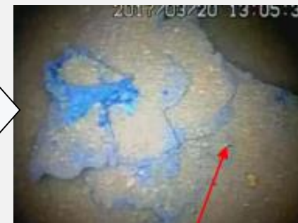
堆積物 1号機内部の様子
