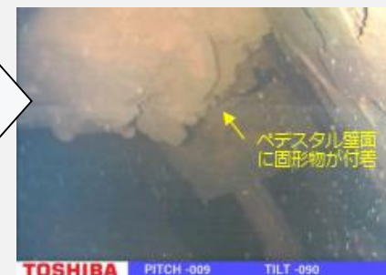
3号機ペDESTAL壁付近の様子
