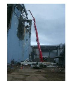
燃料プールの水を確保するためにコンクリートポンプ車の遠隔操作システム開発
