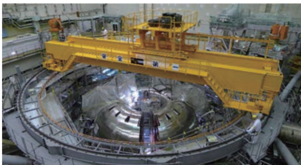
図5 回転クレーン(上部)
