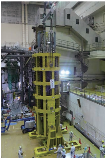
図 12 据付けを待つ超伝導中心ソレノイド(外側部分は治具)
