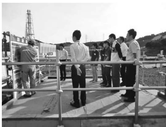
図1 東北電力女川原子力発電所におけるインターンシップの様子(新安全基準に適応した防潮堤の見学の様子)
