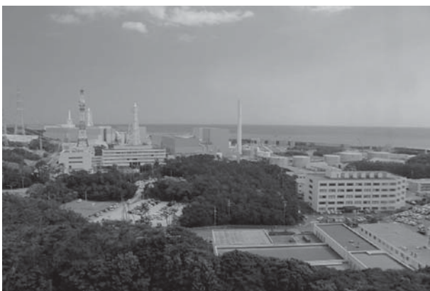
中部電力浜岡原発の全景
