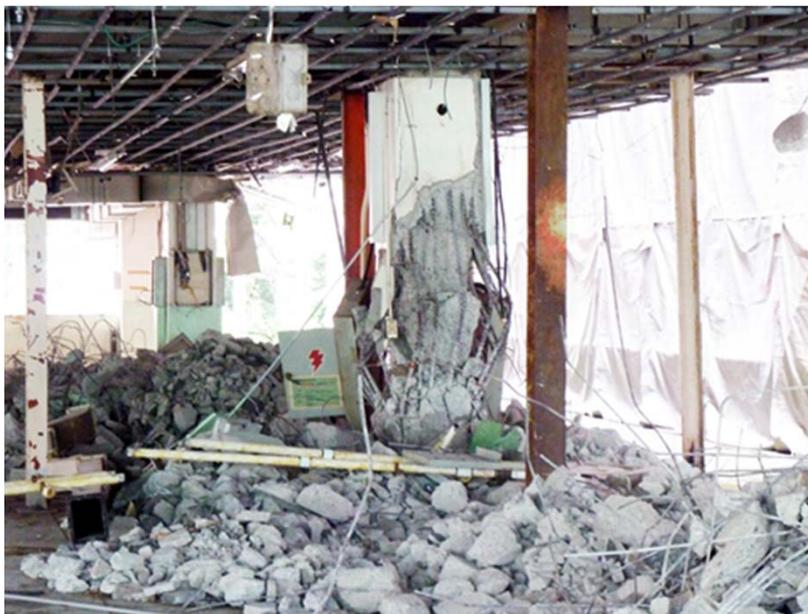
写真2.1.1 PC梁に取り付くRC柱のせん断破壊
