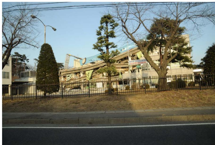
写真2.2.1 3階建て部分の倒壊(西面)
