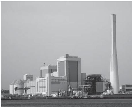
最新鋭 USC プラント (磯子火力発電所600 MW × 2 U)
