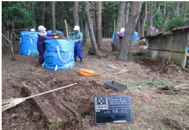
③腐葉土等フレコンバック詰め込み作業
