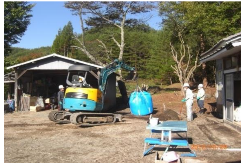
④表土剥ぎ取り作業
