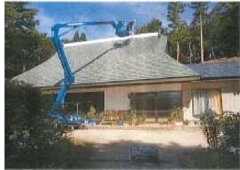
②高所作業車により屋根高圧洗浄機作業
