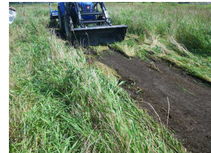
フロントローダーによる 引き剥ぎ
