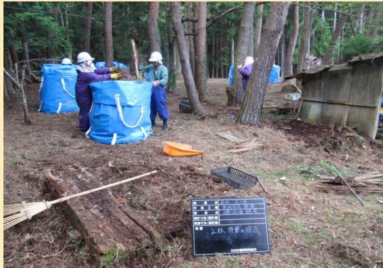
③落ち葉等フレコンバック詰め込み作業
