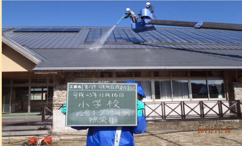
①屋根の高圧洗浄機による除染
