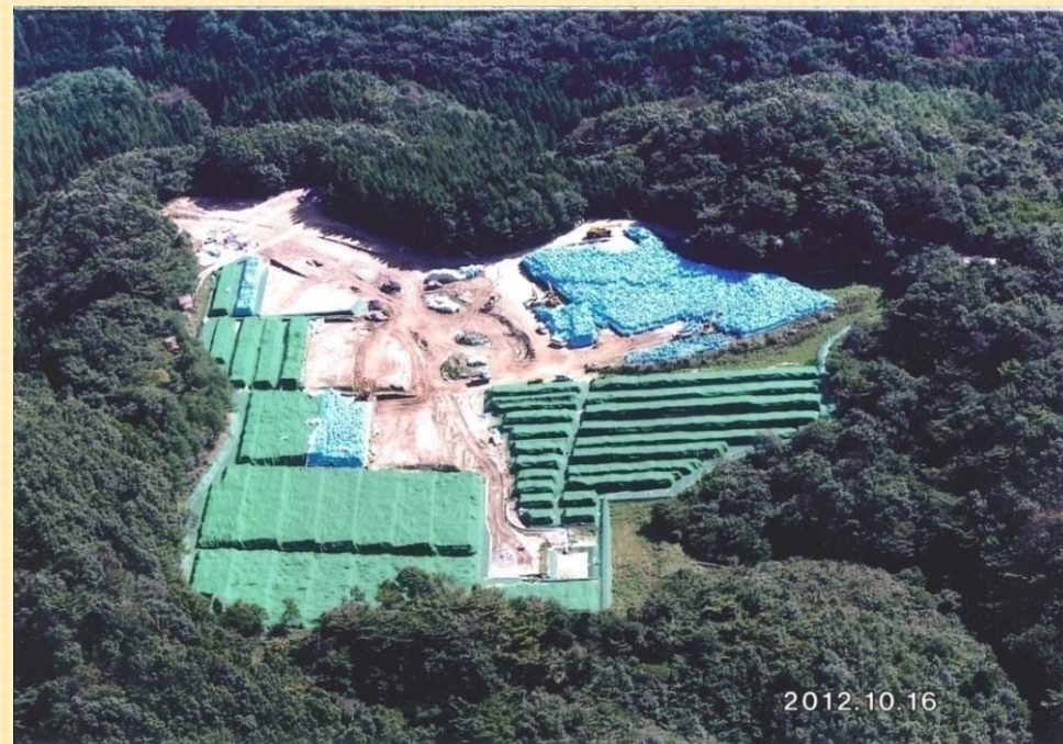
③仮置き場の全景
