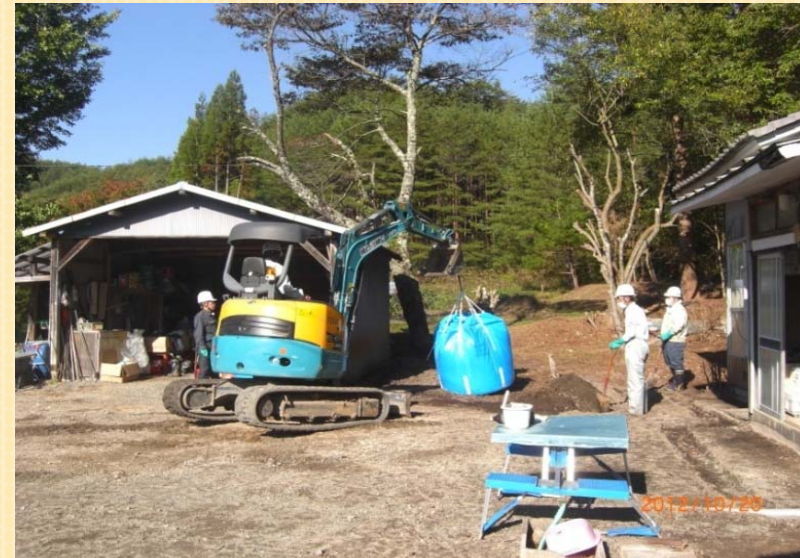
④表土剥ぎ取り作業
