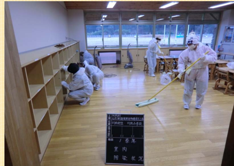
③教室室内の除染
