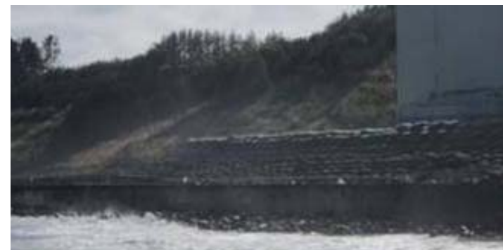
仮設防潮堤設置状況
