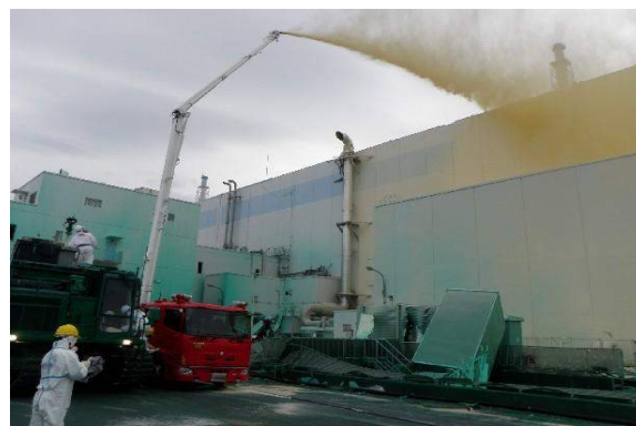
敷地、建屋本体への飛散防止剤散布
