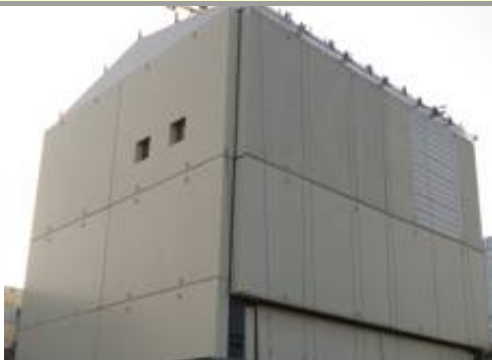
1号機原子炉建屋カバー設置
