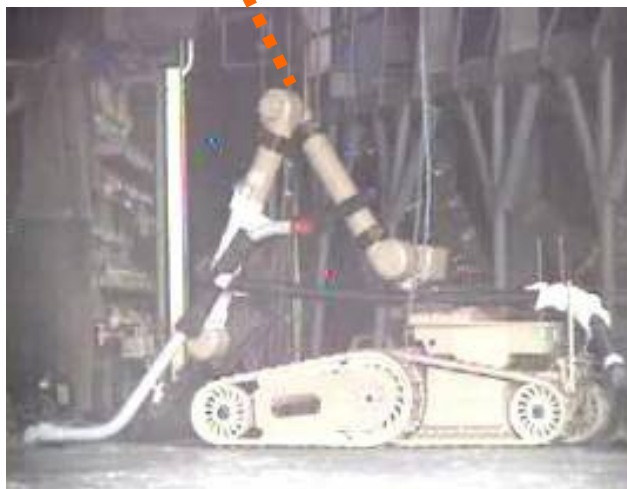
3号機原子炉建屋内清掃作業の様子 （7/1/2011）
