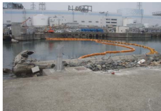
シルトフェンス設置
