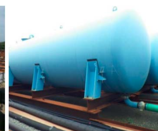
鋼製横置きタンク
