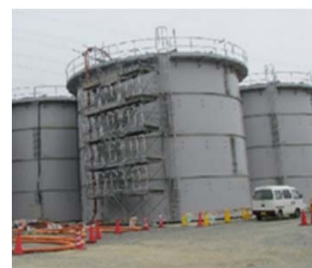
鋼製円筒型タンク （フランジ接合）
