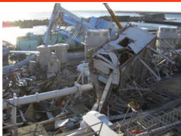
5号機海側海水ポンプエリア
