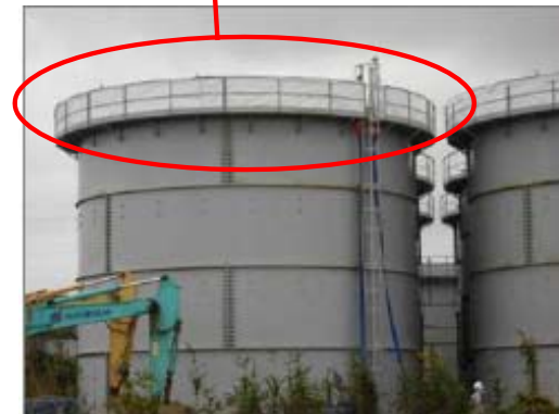
H4エリアタンク仮設雨樋設置状況
