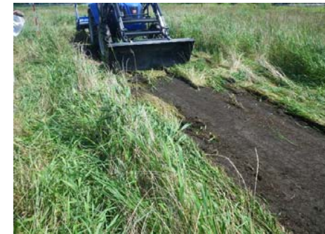
フロントローダーによる 引き剥ぎ
