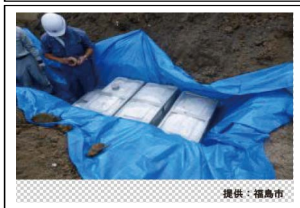
現場保管の例(地下保管)
