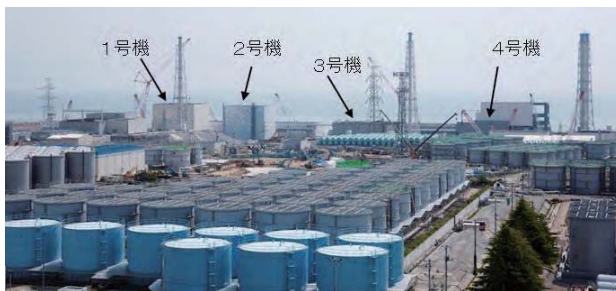
大型休憩所からの眺望（東京電力 HD 提供）
