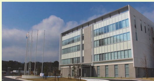
廃炉の技術開発を進める楢葉遠隔技術開発センターの 研究管理棟が完成 (原子力機構提供, p. 9に関連記事)
