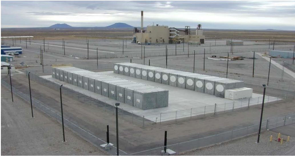
米 TMI-2 燃料デブリの乾式保管施設 [1]
