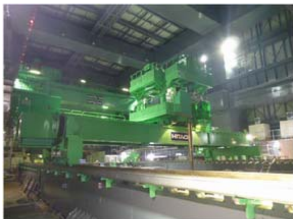
【4号機の燃料取り出し用カバー内部】
