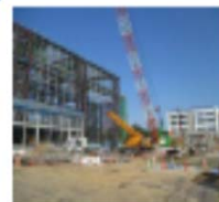
モックアップ試験施設 (楢葉遠隔技術開発センター) 遠隔操作機器の開発・実証(除 染、観察、補修)等を実施
