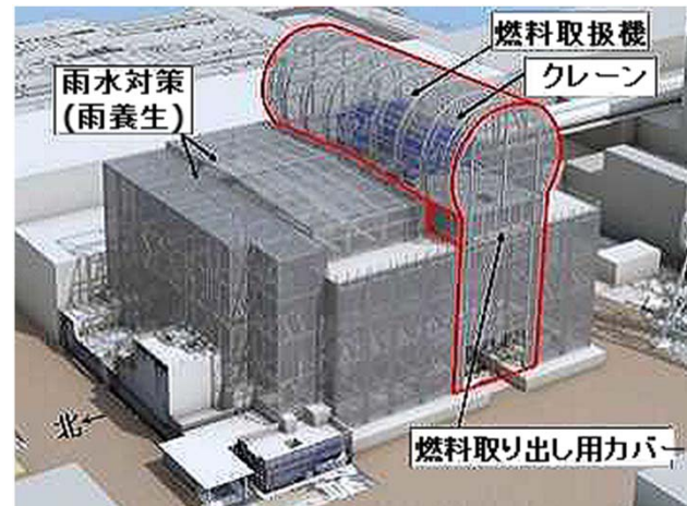
3号機燃料取り出し用カバーイメージ図
